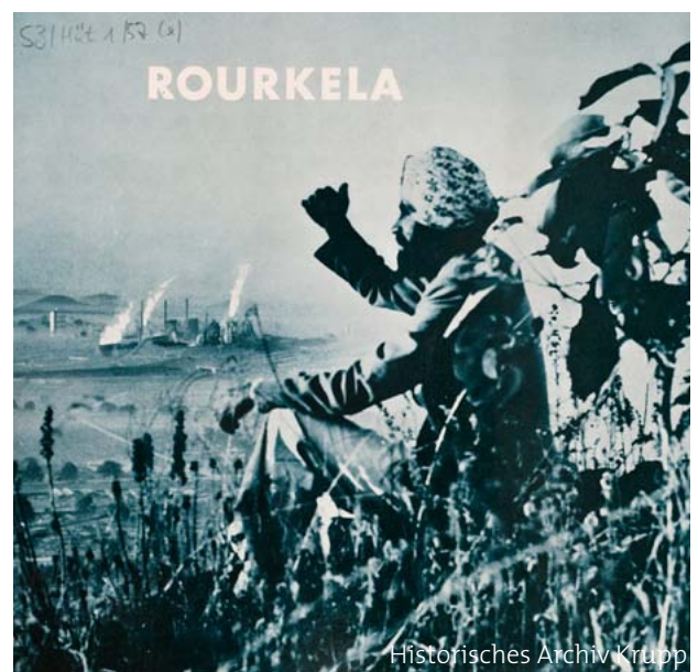
Blick auf das Stahlwerk Rourkela in Indien, 1960
